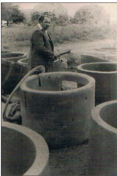
Jan Szol i betonowe kręgi do budowy studni
