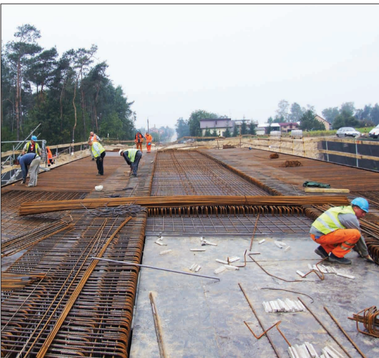
Tak powstaje most na drodze do Romanowa, za kilka dni zbrojenia zaleje beton. Skanska zamierza uruchomić przejazd przez ten most jeszcze w tym roku. Mieszkańcy Romanowa, szczególnie młodzież szkolna, będą mogli bez przeszkód dojeżdżać do Rzgowa.
