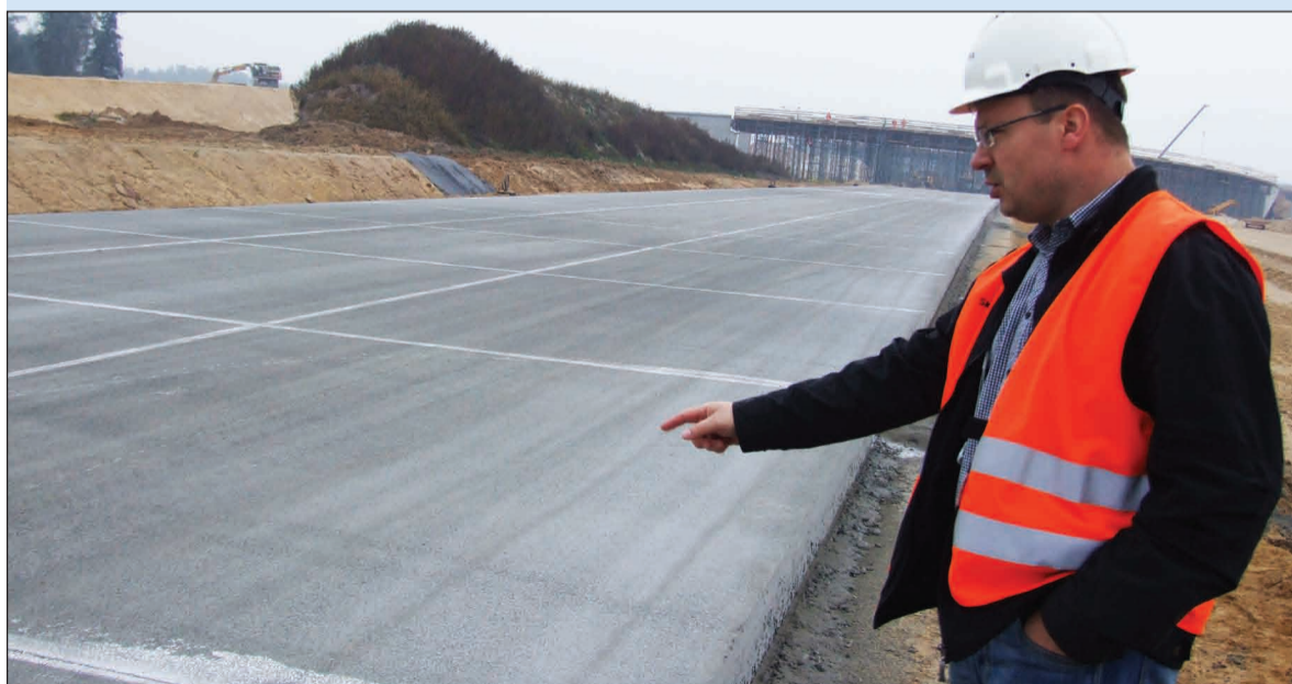
Dyrektor Ryszard Aszyk przy betonowej jezdni autostrady w rejonie Romanowa
