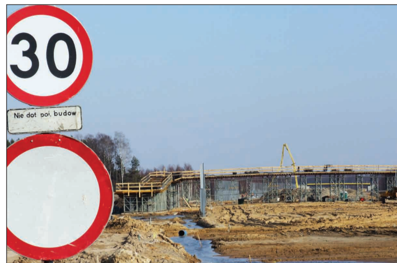
W rejonie Czyżeminka przy drodze ekspresowej S-8 powstaje tzw. MOP, czyli miejsce obsługi podróżnych, z wielkimi parkingami i kładką nad dwujezdniówką
