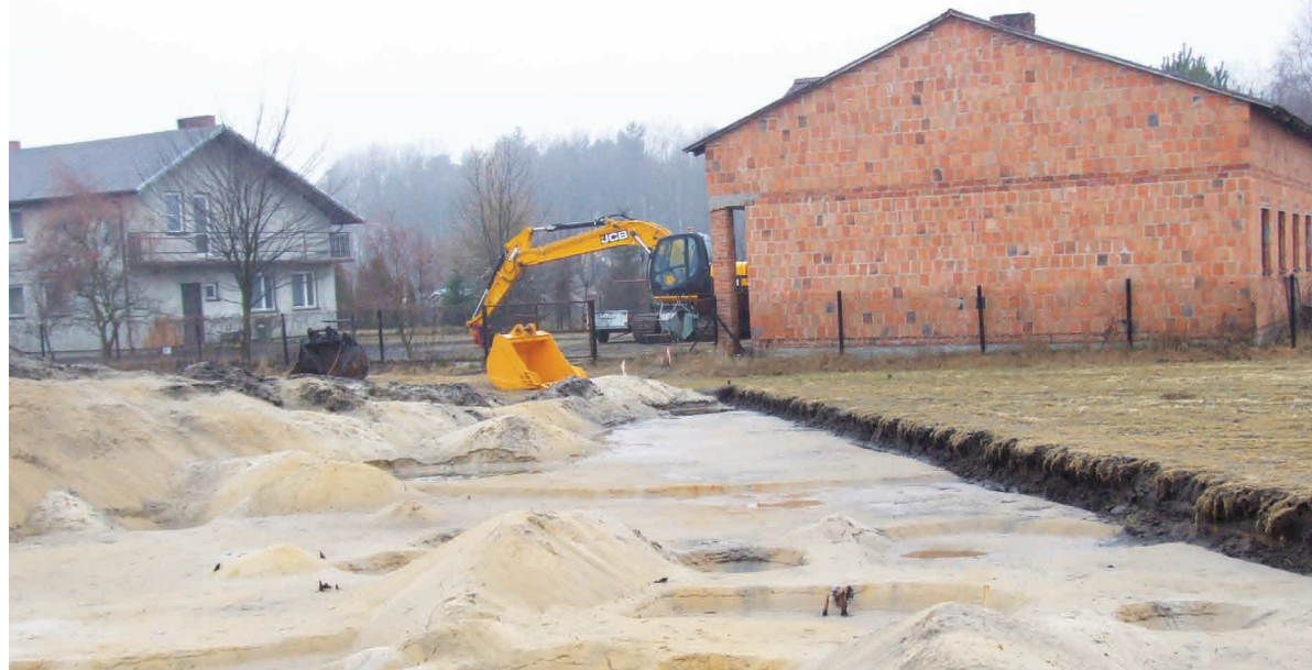
Czyżeminek, tu niedługo rozpocznie się budowa wiaduktu
