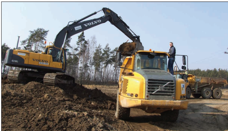
W rejonie Romanowa i innych miejscowości gminy Rzgów trwają już roboty ziemne związane z budową nowych arterii komunikacyjnych, ale sprawy związane z wykupem gruntów przez państwo do dziś nie zostały należycie załatwione. Właściciele ziemi nie wiedzą też, ile otrzymają pieniędzy, jak wyceniono ich własność...
