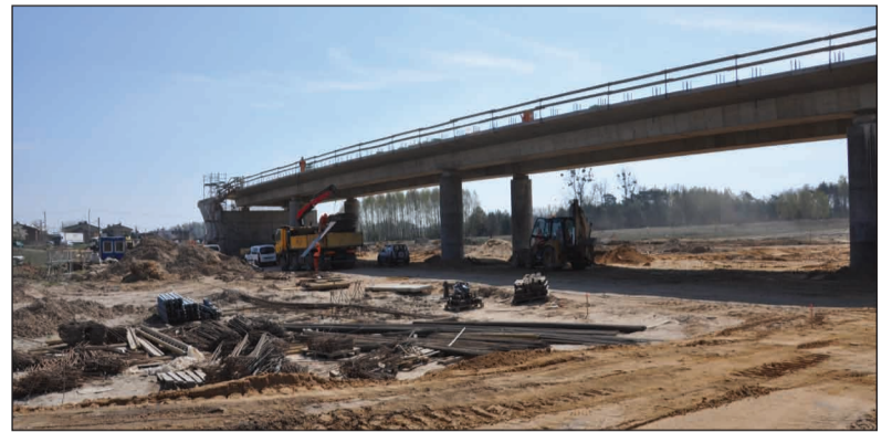
Budowa wiaduktu w Woli Rakowej, gm. Brójce
