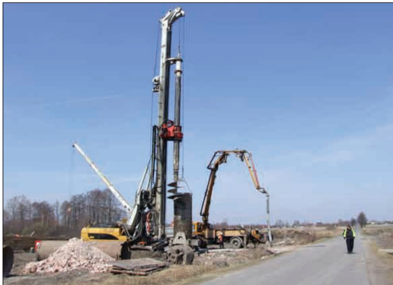
Roboty poprzedzające budowę mostu w rejonie Guzewa
