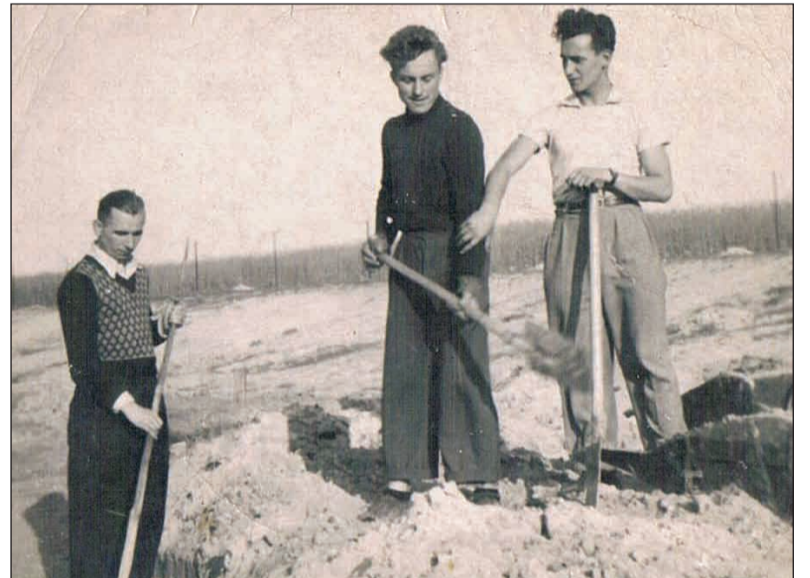
Budowa stadionu w Rzgowie, od lewej Henryk Śmiechowicz (jeden z inicjatorów powstania tego obiektu), Mirosław Fracala i Kazimierz Salski. Ze zbiorów Z. Rechcińskiego
