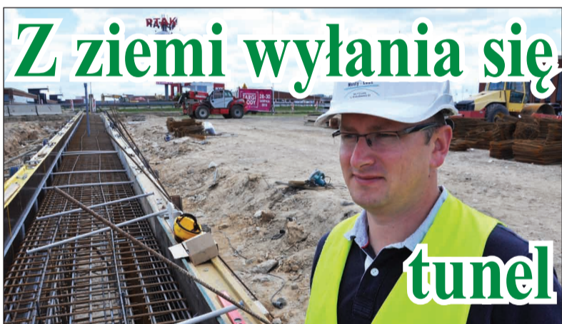
Inżynier Michał Guzek przy jednej ze ścian szczelinowych
